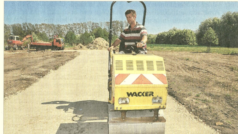
Tobias Meier legt den künftigen Rundweg des Campingplatzes an. Schon bald sollen auch Wasser- und Stromanschlüsse folgen.
